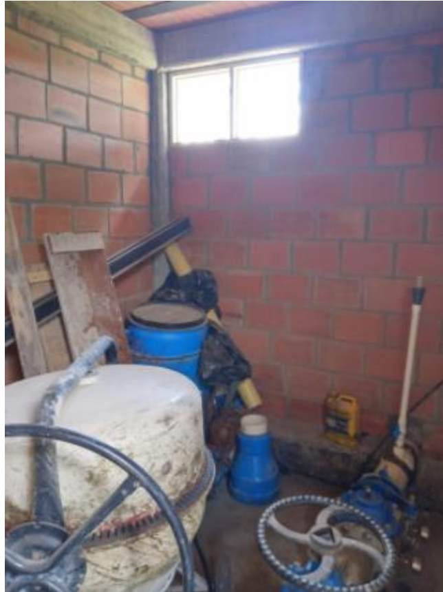
FOTO 2: LUGAR DE INSTALACION
